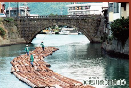
⑩堀川橋(日向市)
