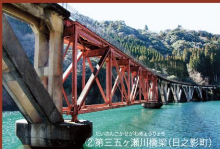
②第三ヶ瀬川橋梁(日之影町)
