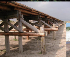
上津屋橋~木津川の流れ橋 京都府 昭和28年(1953年)架設 (今春大改修された)
