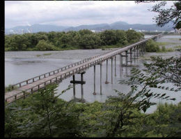
世界一長い木橋 蓬莱橋 橋長897m 静岡県 明治12年(1879年)架設
