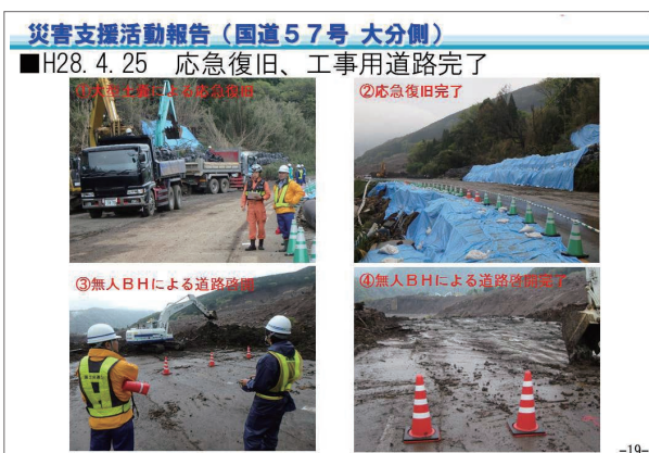
災害支援活動報告（国道57号大分側 平成28年4月25日 応急復旧 工事用道路完了）
