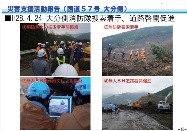
災害支援活動報告（国道57号大分側 平成28年4月24日 大分側消防隊創作着手、道路啓開促進）
