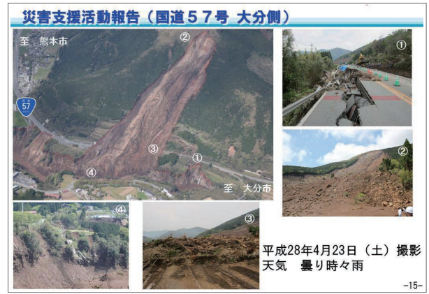
災害支援活動報告（国道 57 号大分側） 平成 28 年 4 月 23 日（土）撮影 天気 曇り時々雨
