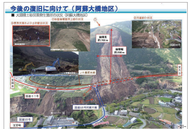
今後の復旧に向けて（阿蘇大橋地区） 大規模土砂災害発生箇所の状況
