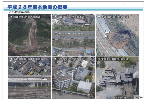
平成 28 年熊本地震の概要 被災状況
