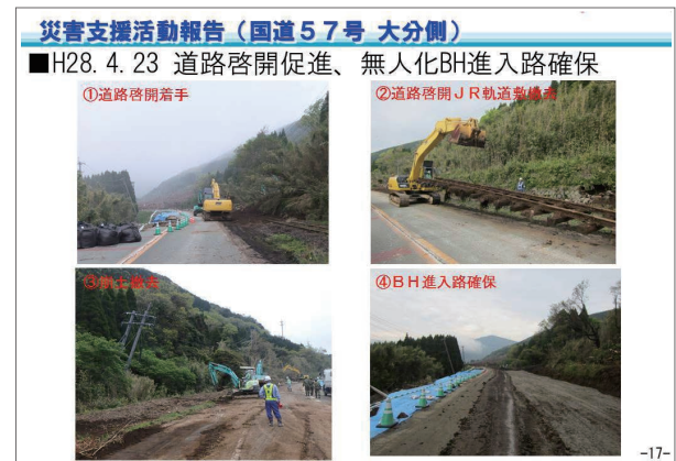
災害支援活動報告（国道 57 号大分側 道路啓開促進、無人化 BH 進入路確保）
