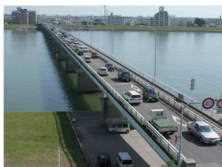
工事前の小戸之橋
