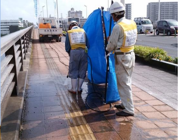
■点字ブロックの清掃(協力:宮崎県鋼橋コンクリート構造物塗装協同組合)
