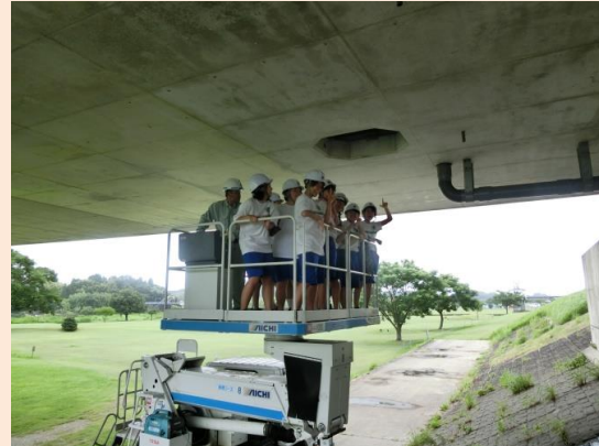
高所作業車も初体験。
