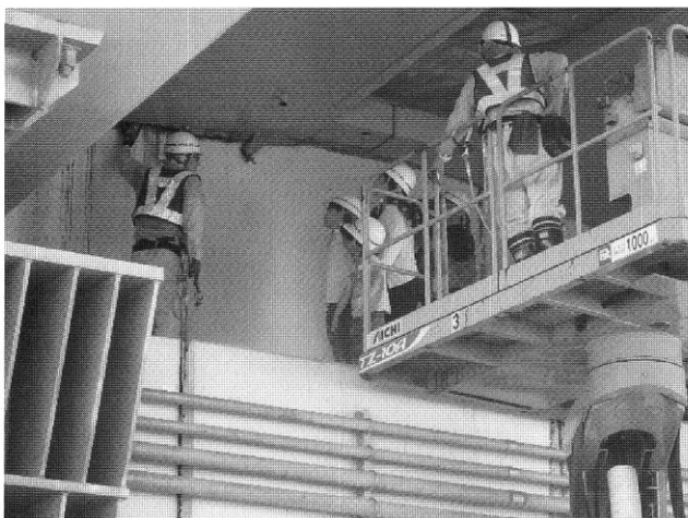
写真-6 橋の内部見学会
